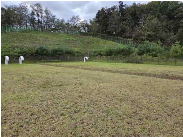
<배수지 상부 전경>
