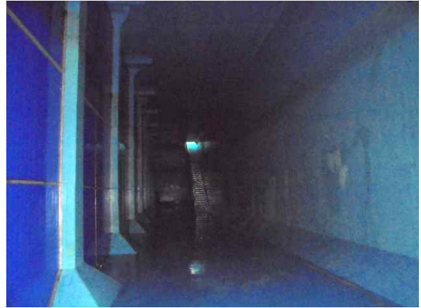
<배수지 2지 전경>
