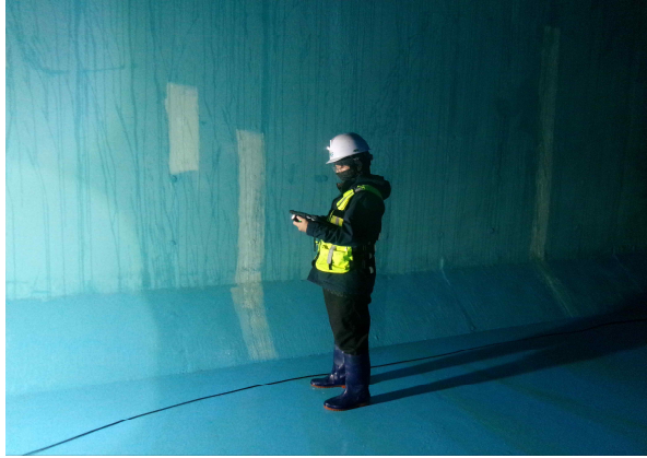
<내부 개별부재 외관조사>
