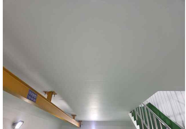
<유입밸브실 내부 상부슬래브 양호>
