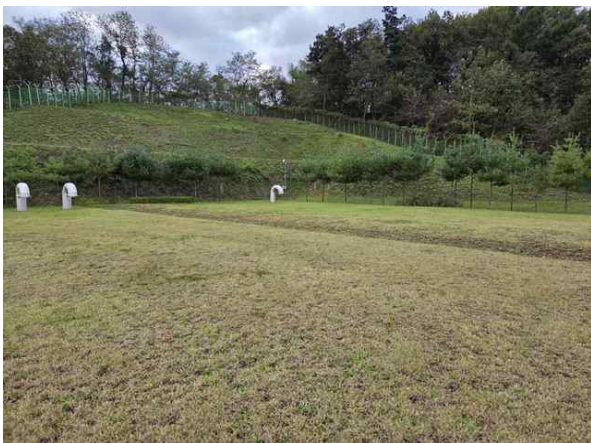
<배수지 상부 현황>
