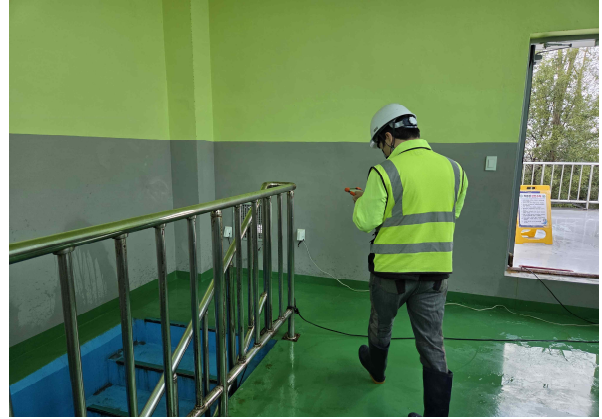
<내부 개별부재 외관조사>
