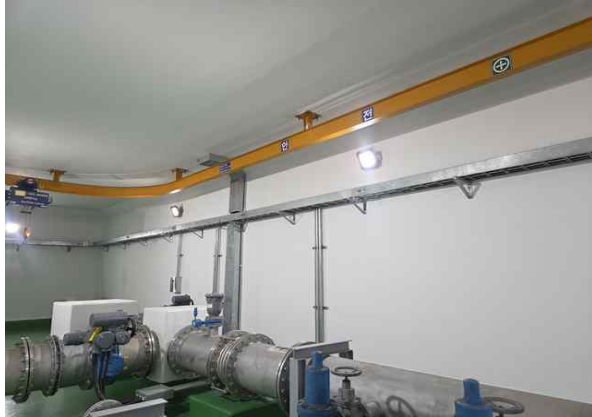
<유입밸브실 내부 벽체 양호>
